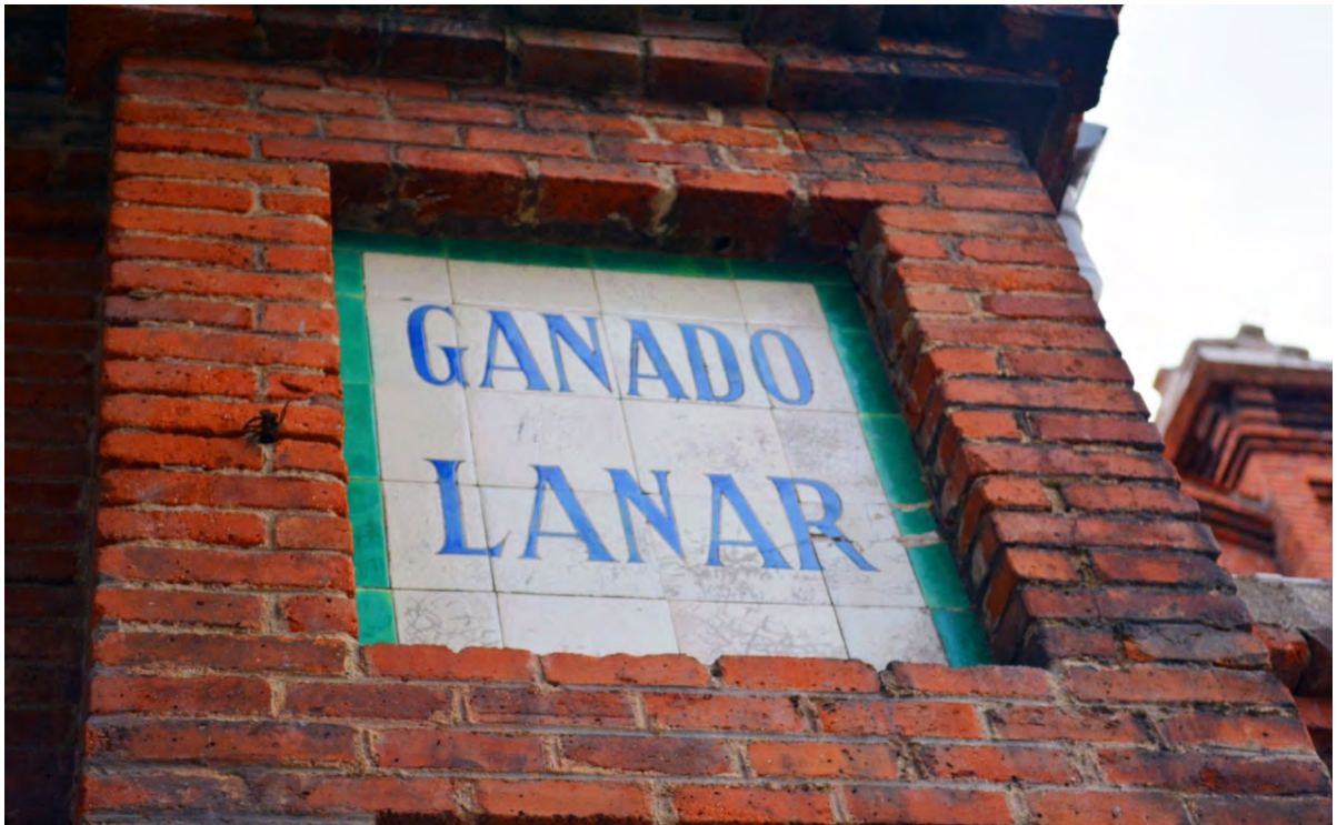
Figuras 14 e 15: Atualmente ainda estão no Matadero de Madrid, a sinalização relativa aos galpões de abate (Neste caso, abate de gado ovino). 29 de outubro de 2015. Foto: Rafaela Jemmene.
